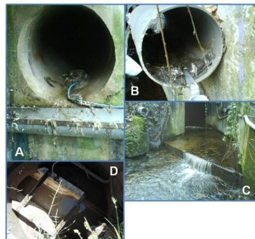
Figure 40: Profil en long du secteur fortement impacté par le déversoir d'orage de la station expérimentale de la rivière Chaudanne à Grézieu-la-Varenne, et photos du (A) canalisation de décharge du déversoir d'orage, (B) canal de dérivation pour la collecte des eaux du DO, (C) zone de rejet du DO au niveau de la rivière Chaudanne (amont fosse), et (D) réseau unitaire.
