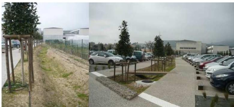
Le fractionnement du parking Raynouard par des noues enherbées avec de la prairie méditerranéenne facilite l'infiltration des eaux pluviales. L'utilisation de matériaux spécifiques pour les voies piétonnières et les stationnements permet de réduire l'imperméabilisation aux seules voies de circulation.
