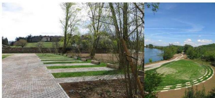
Le remplacement d'un terrain de basket et d'un parking en enrobé par un amphithéâtre de verdure perméable et d'un parking herbagé permet d'infiltrer l'eau de pluie là où elle tombe.
