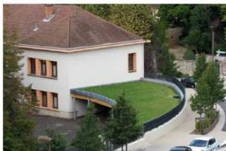
Charbonnières-les-Bains a réalisé des travaux permettant de déconnecter les eaux de pluie du réseau d'assainissement mais aussi de réaliser des économies d'eau.
